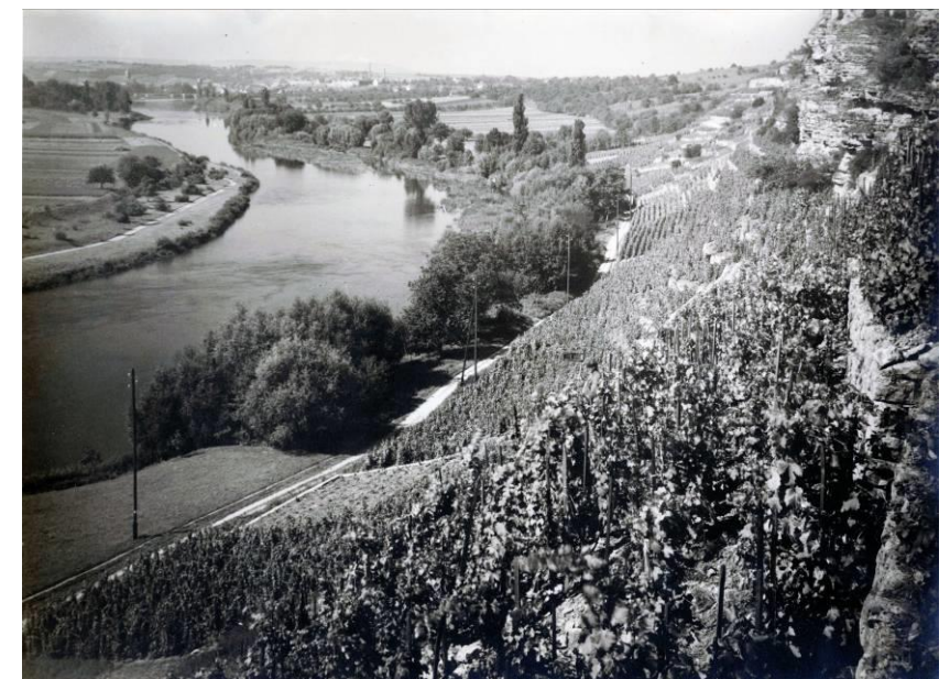
Abb.2: Neckar bei Lauffen – vor dem Ausbau
