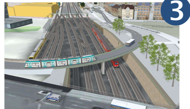
Fotomontage: Auf einer neuen Keplerbrücke könnte die Stadtbahn aus der Weststadt den ZOB erreichen. Auch Stadtbusse können diese Brücke nutzen, ohne im Stau zu stehen.
